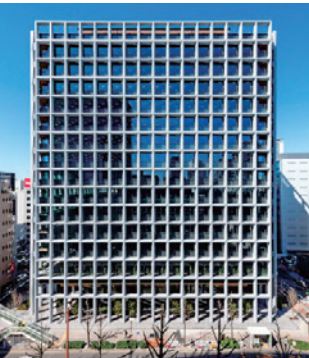
名古屋シンシス富田生命ビル 二〇二三年度竣工
