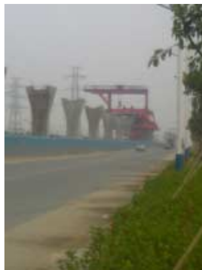
写真. 開発区の工事状況
